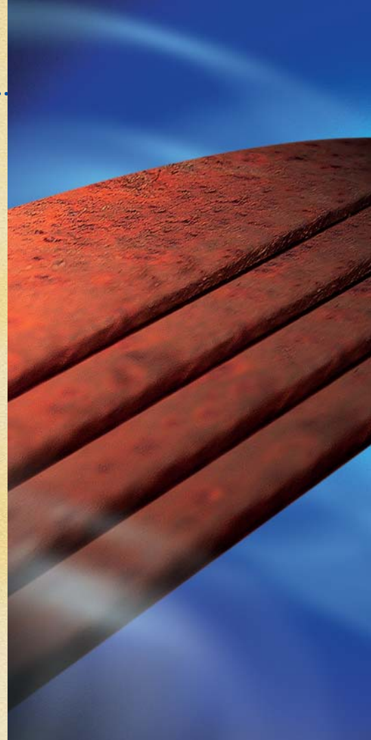
L'humidité relative de l'air provoque une corrosion atmosphérique si elle n'est pas traitée correctement
